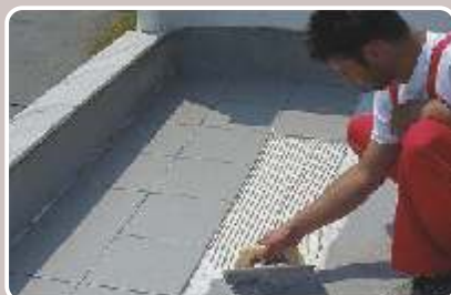
Η κόλληση των πλακιδίων γίνεται με χρήση της ελαστικής κόλλας Isomat AK-ELASTIC .
