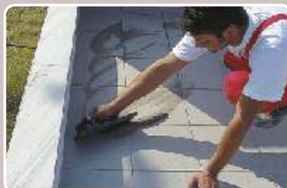
Η αρμολόγηση γίνεται με MULTIFILL 3-15 ενισχυμένο με τη ρητίνη DS-99 .
