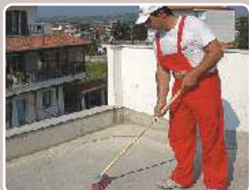
Αρχικά καθαρίζεται καλά το υπόστρωμα από σκόνες, σαθρά υλικά κλπ.
