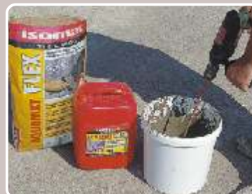
Παρασκευάζεται το AQUAMAT-FLEX , με προσθήκη του Α-συστατικού (κονία) στο Β-συστατικό (ελαστικοποιητής) και ταυτόχρονη ανάμιξη.
